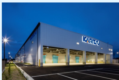
LED 照明の拡大
