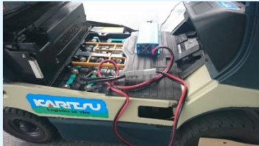
非常用電源装置
